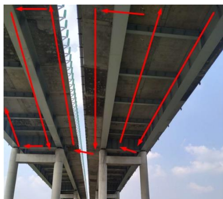
图A.1 梁底巡检路线制定
